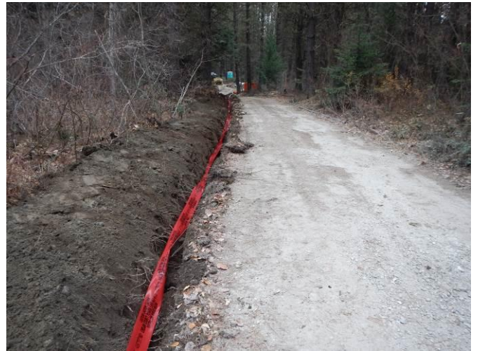
New powerline conduit.
